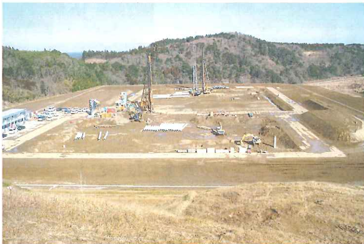
平成16年1月中頃から新施設建設の杭打ち工事が始まりました。
