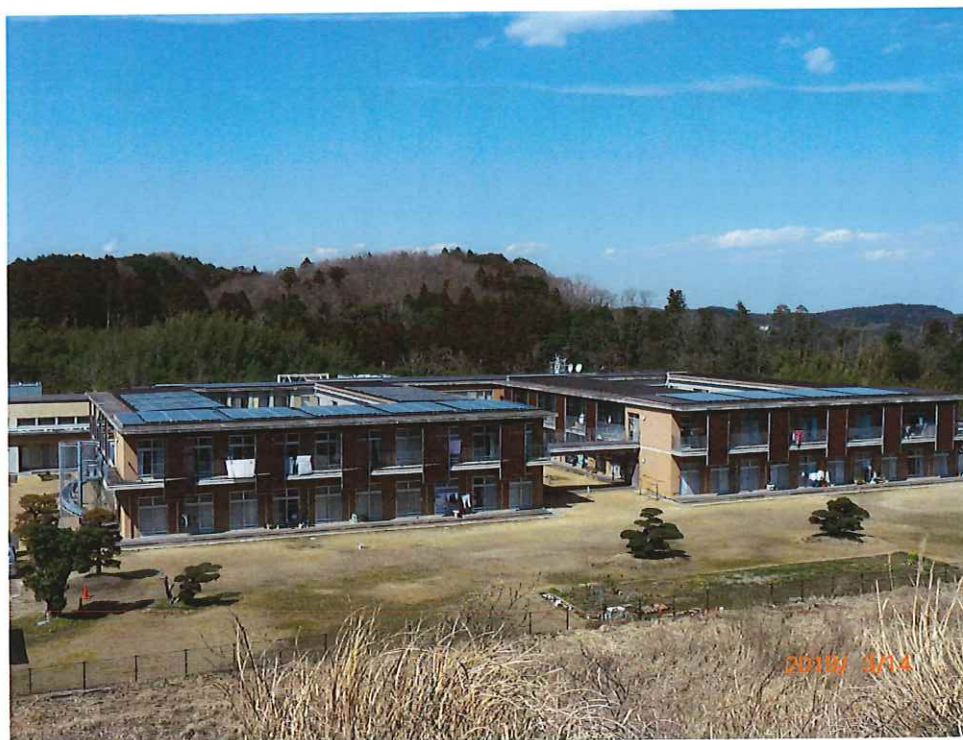
(溪泉荘 A 棟・B 棟屋根に設置したソーラーパネル)
